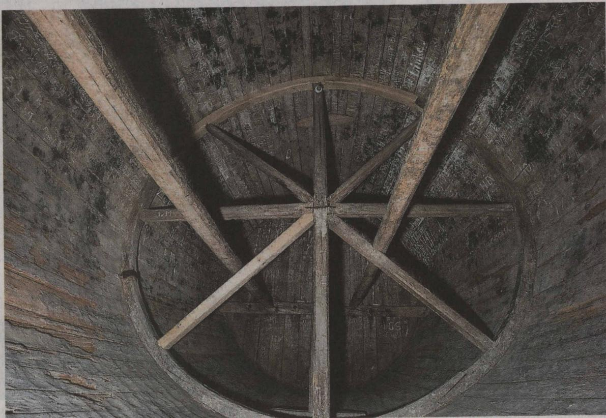
Das Tübinger Fass fasst knapp 84 Kubikmeter. Und so sieht es im Inneren aus – mit der Stützkonstruktion, die ihm einen Teil des Volumens nimmt.
