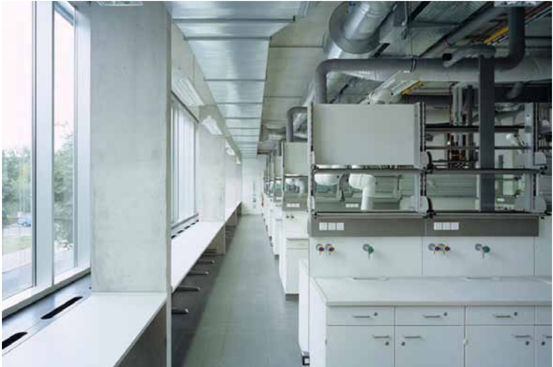
Abb. 1 Burger Rudacs Architekten, Laborgebäude HTW Dresden, Laborraum
